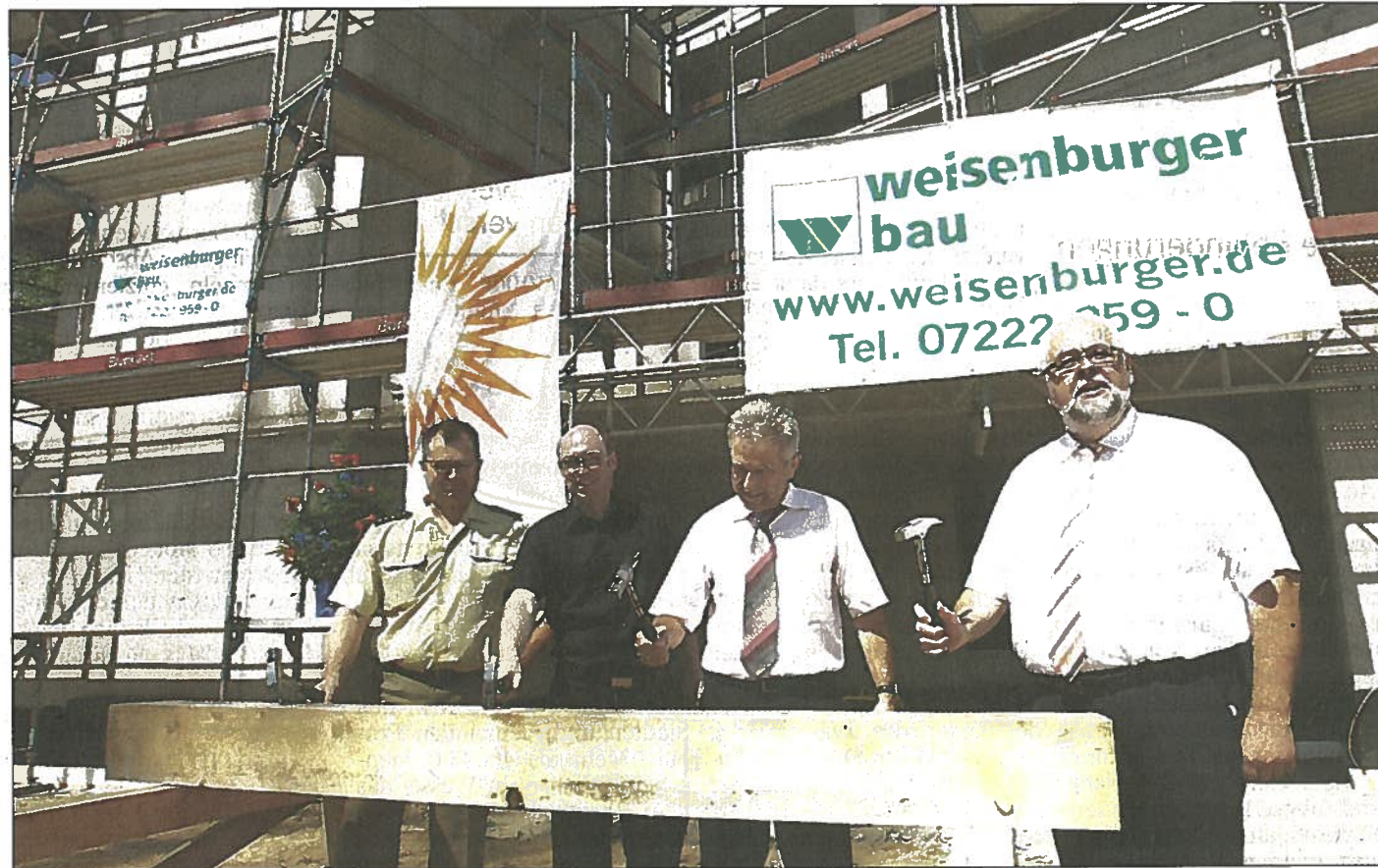
Richtfest für den neuen Polizeiposten in Bietigheim: Die letzten Nägel werden von Postenleiter Peter Oberle, Architekt Andreas Bohr, PD-Chef Kurt Wintermantel und Bürgermeister Ernst Kopp (von links) eingehämmert.
